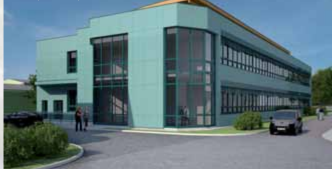
Technologické Centrum Univerzita Palackého Technological Centre Palacký University
